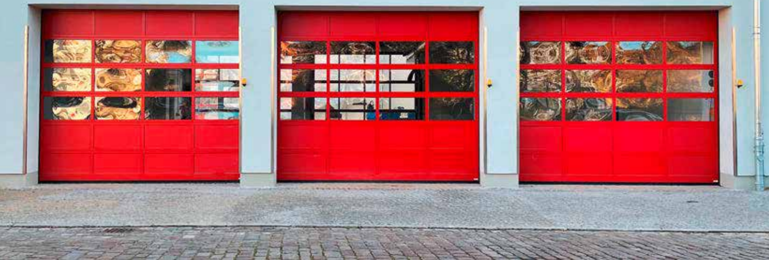
Neue Toranlage der Feuerwache Köpenick Bild: BIM GmbH
