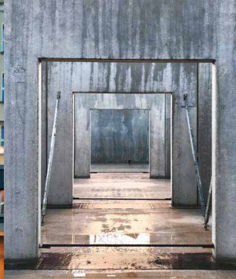
Rohbau der Freiwilligen Feuerwehr Grünau Bild: Steiner Weißenberg Architekten
