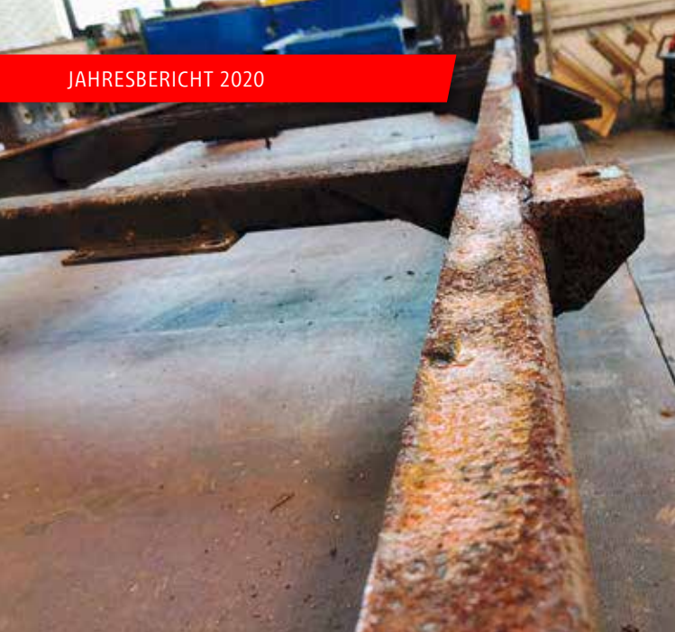
Vorher: korrodierter Rahmen
