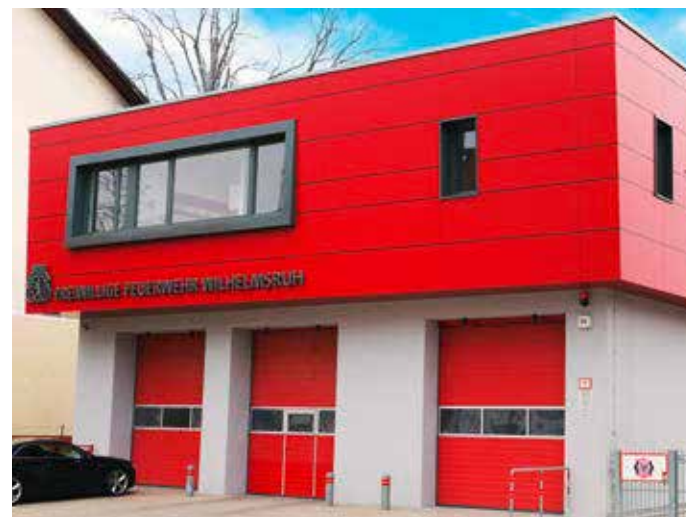
Straßenansicht der Freiwilligen Feuerwehr und Rettungswache Wilhelmsruh Bild: Kadel-Quick-Scheib Architekten
