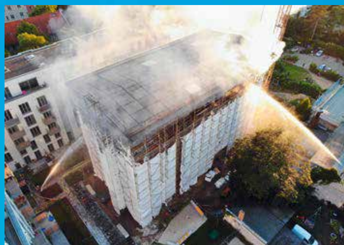
Durch den Einsatz von Thermografiebildern kann der Einsatz der Löschmonitore gezielt gesteuert werden.
