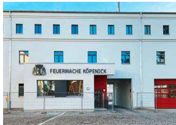
Die neue Fassade der Feuerwache Köpenick Bild: BIM GmbH
